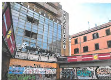
UNO DEI LUOGHI DELLA MIA ADOLESCENZA In foto c'è quel che resta del cinema multisala Maestoso di Roma, chiuso nel giugno 2018, che frequentavo da adolescente con mia madre e il suo compagno. Ora se ne sta ipotizzando il recupero.
